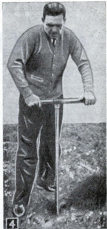
4 Attrezzo per iniziare il foro in cui andranno introdotti, uno dopo l'altro, gli elementi di tubo.
